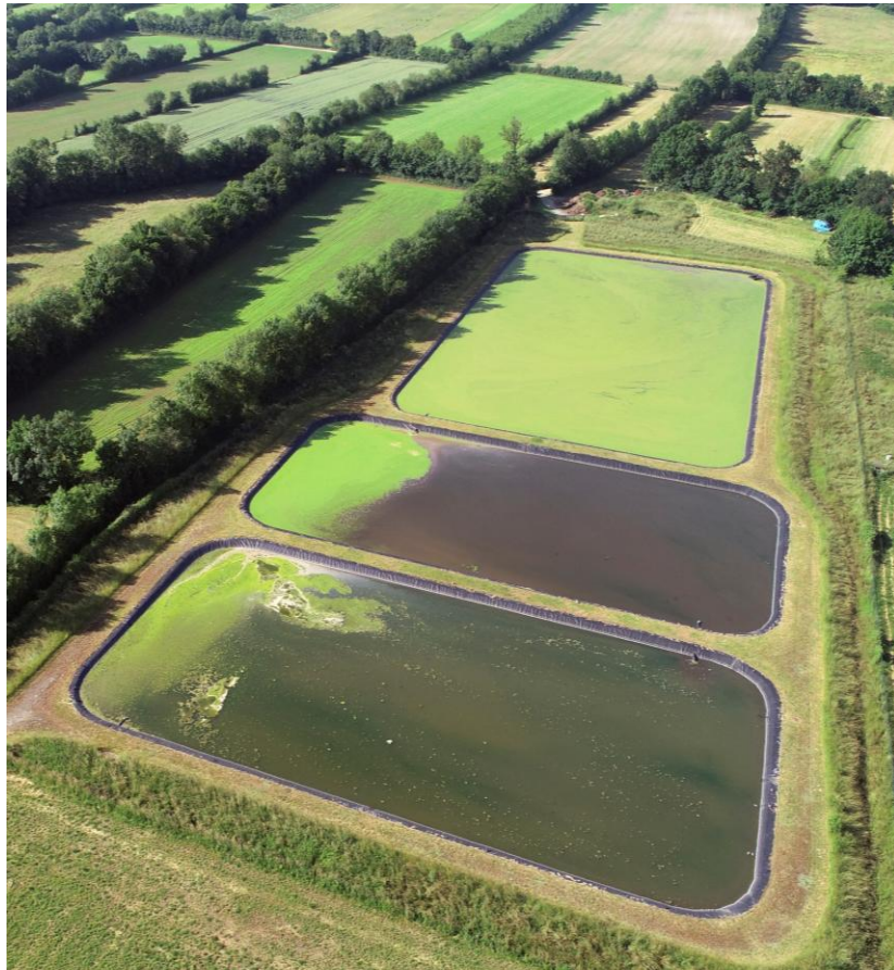
Bassin de rétention dans les Deux-Sèvres
