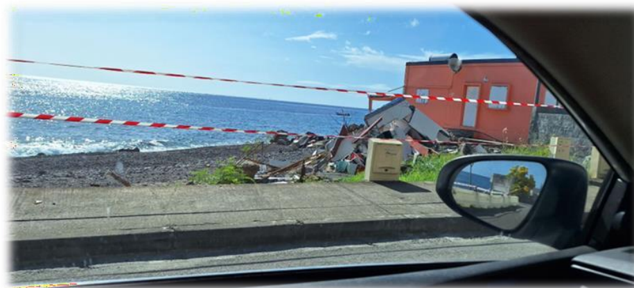
Entrée bourg du Prêcheur, 22/08/24
