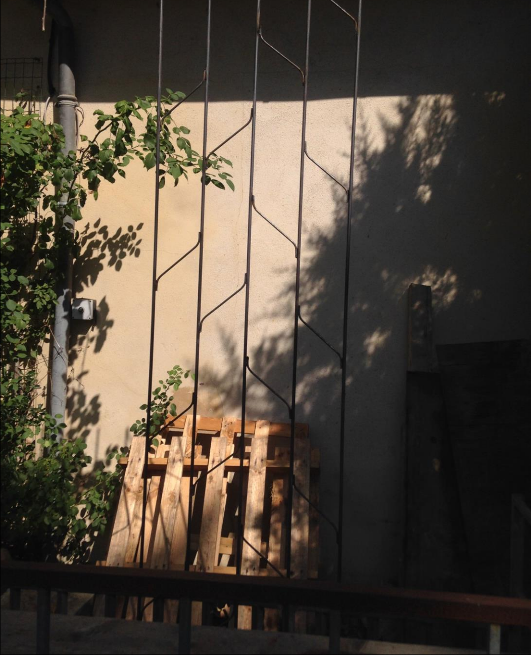
Support métallique fabriqué en atelier en attente de pose
