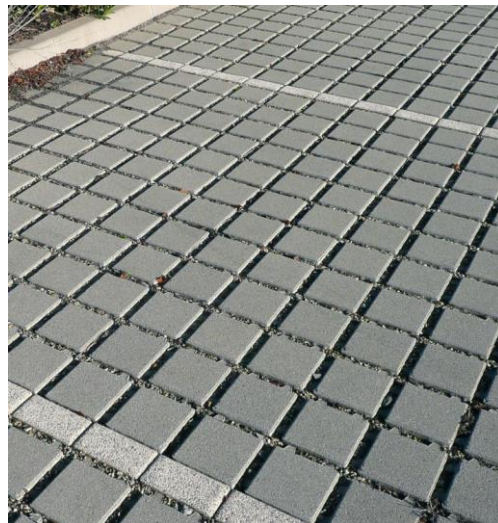
Pavés béton joints sable
