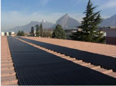
Exemple de capteurs souples pour produire de l'eau chaude pour sanitaire (source: heliopac.fr)
